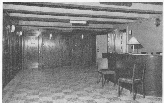
Abb. 7. Kabinen-Vorraum der Kunden-Safes im Untergeschoss.
