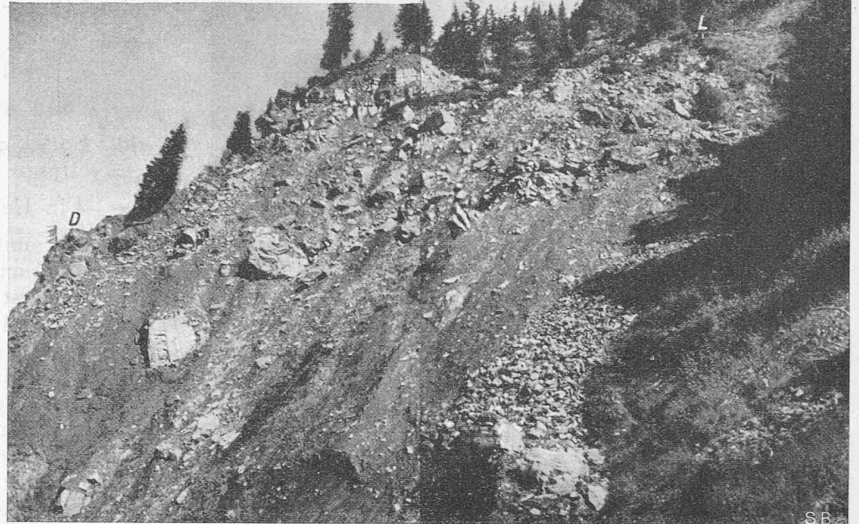
Abb. 4. Zustand des Rutschgebietes Ende August 1933, Standpunkt rd. 20 m oberhalb der Stockhütte (St.).
