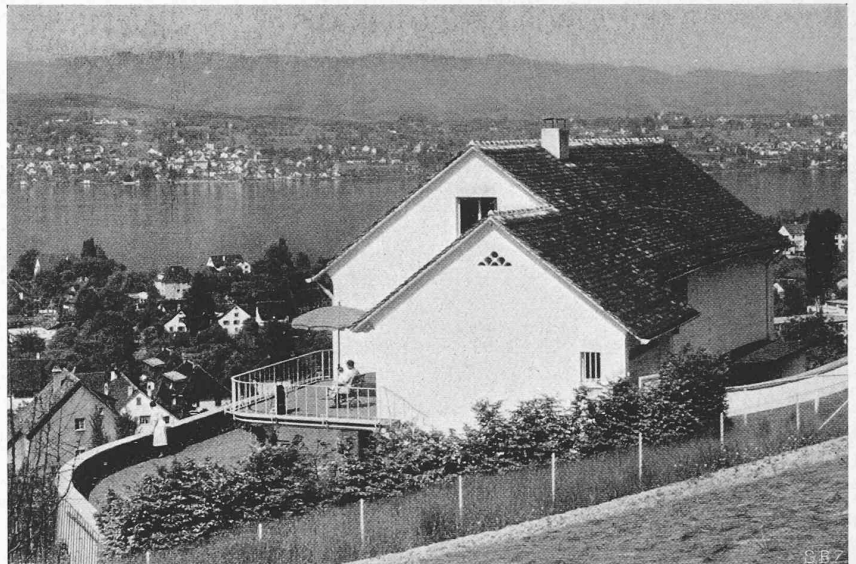
Abb. 3. Haus Dr. Weckherlin, Ansicht aus Osten. — Arch. Laubi & Bosshard, Zürich.
