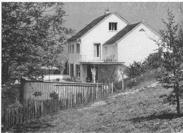
Abb. 2. Gesamtbild des Hauses Weckherlin aus Südosten.
