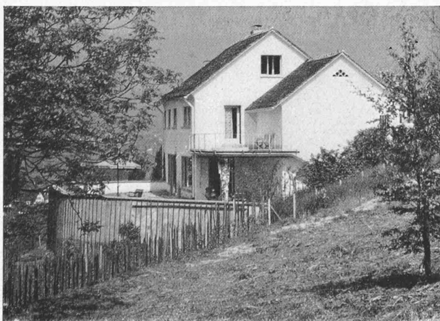
Abb. 2. Gesamtbild des Hauses Weckherlin aus Südosten.
