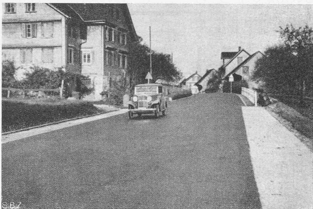
Abb. 10. Glarner Kantonstrasse zwischen Kantonsgrenze Schwyz und Biltlen. Gehwege mit hellem Splittbelag (die Prellsteinpfosten fehlen noch).
