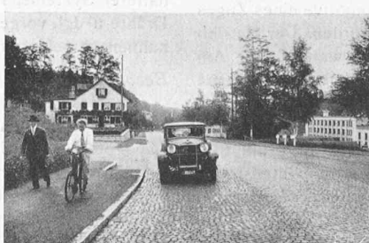
Abb. 3 (oben). Dorfstrasse II. Kl. im Tösstal. Abb. 4. Winterthurerstrasse, Gehweg mit Radfahrweg vereinigt (Auffahrt-Rampen).
