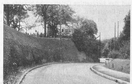
Zürcherische Kant. Strasse II. Kl., Gubel bei Wald. Abb. 5 aufwärts, Abb. 6 abwärts: Sichtweite 90 m; R 90 m und 70 m; Gefälle 8%; Kleinplästerei.
