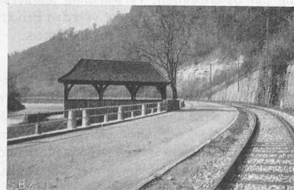
Abb. 1 u. 2. Sihltal-Strasse u. -Bahn, vor und nach Ausbau der Strasse. Umbau eines Schleusen-Bedienungshäuschens zur Verbesserung der Sicht.
