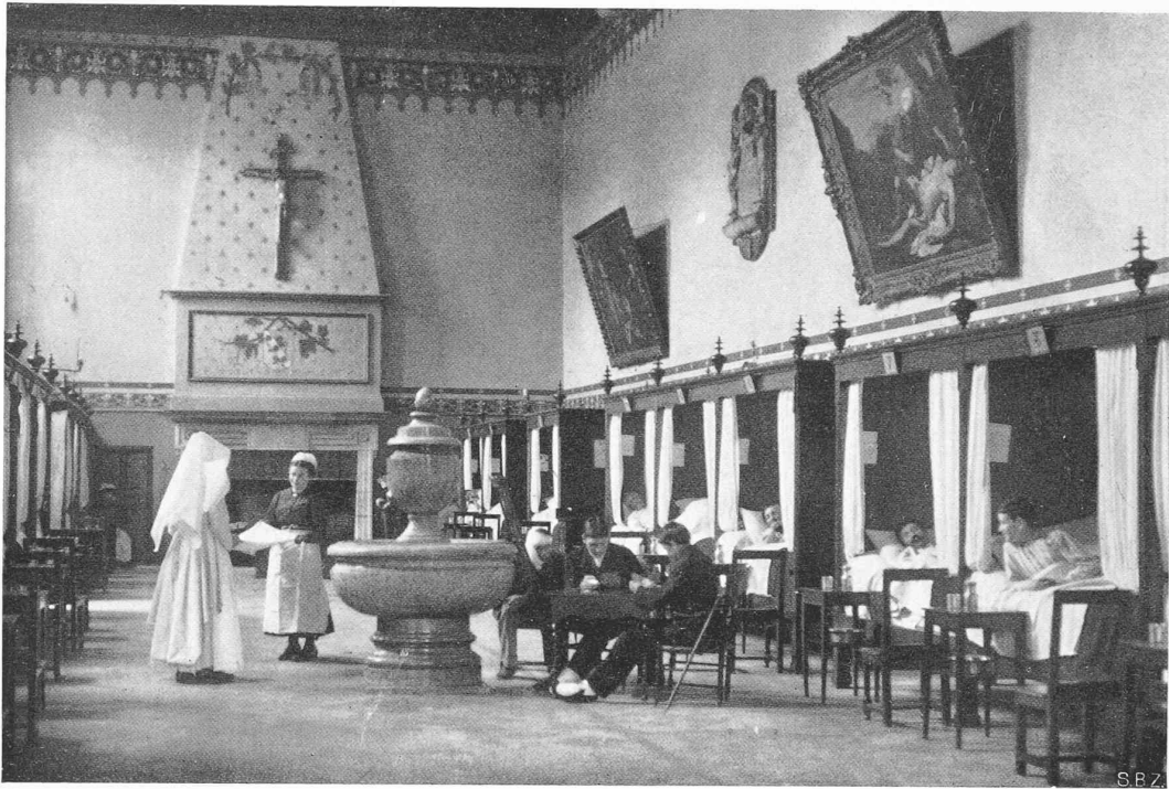
Abb. 8. SALLE SAINT-LOUIS, RESTAURIERT IM XVII. JAHRHUNDERT
