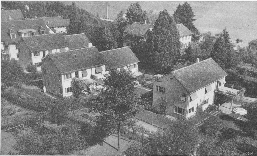
Abb. 2. Südöstlicher Teil aus Süden, rechts Haustyp A, links Doppelhäuser B.
