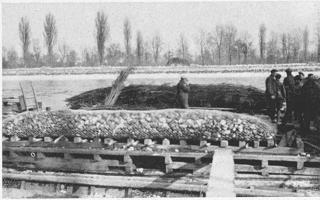
Abb. 15. Wacken-Senkwurf mit Drahthülle; dahinter Faschinenwurf.
