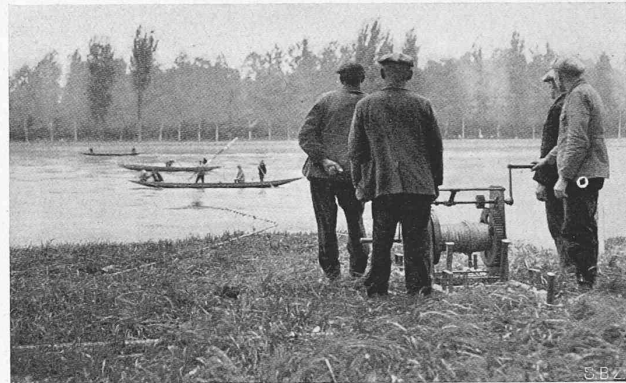
Abb. 18. Profilaufnahme bei bad. Km. 100.
