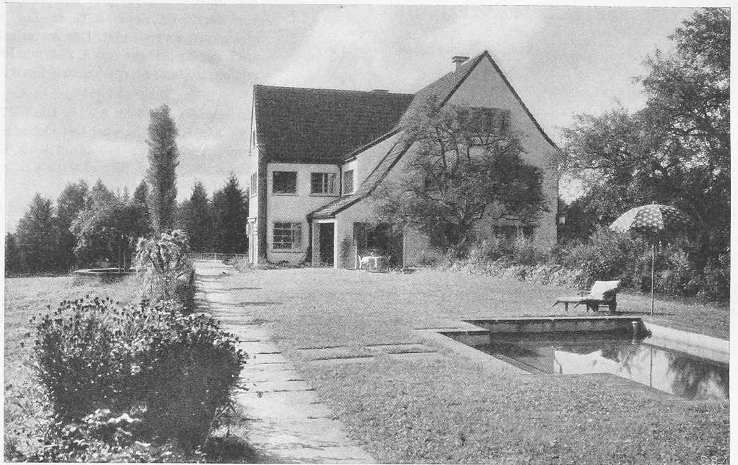
Abb. 5. Ansicht aus Osten, in Mittagsbeleuchtung (das Badebecken vorn rechts ist versehentlich nicht bordvoll).
