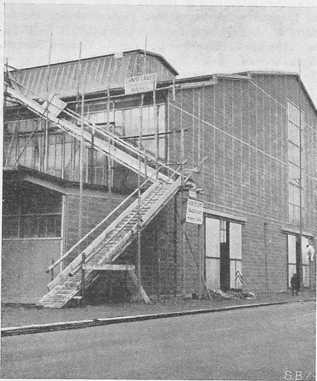
Abb. 7. Stirnseite Sperrstrasse der fertigen Halle VI.
