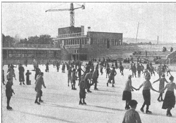
Kunsteisbahn in Bern, ca. 4000 m 2 Kork- und mehrlagige Panne-Isolierung.
