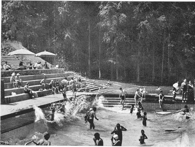
Abb. 7. Südende des Schwimmbeckens mit den Sitzstufen (Wellenschlag mässig).
