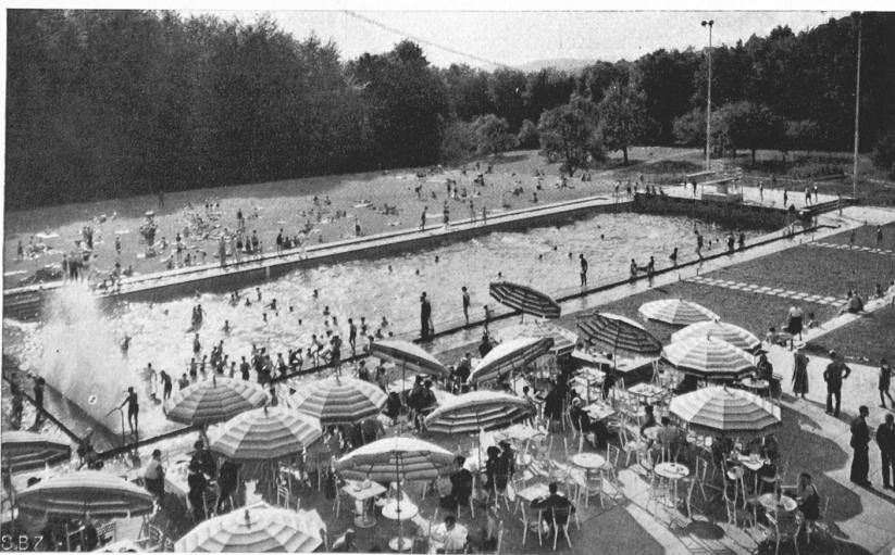
Abb. 9. Gesamtbild aus Osten mit grossen Brandungswellen am Südende. (Photoglob Zürich).
