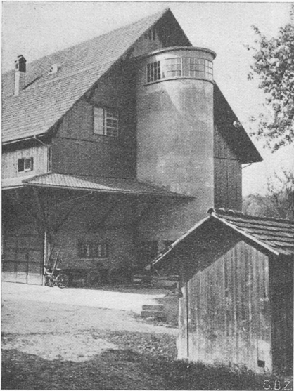
Abb. 4. Nordwestseite der Scheune mit Silo.
