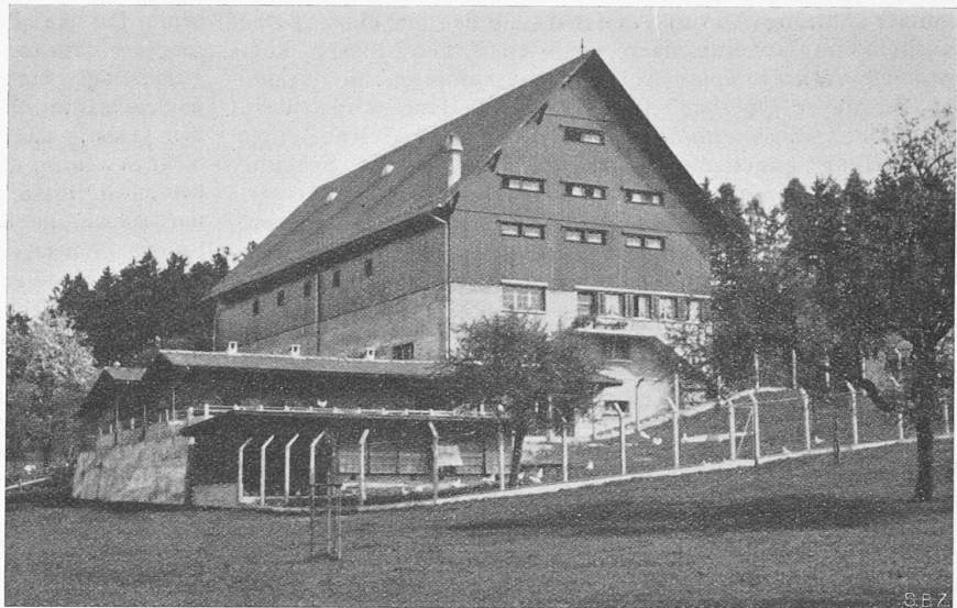
Abb. 8. Südansicht der Lettenhof-Scheune, im Vordergrund der Hühnerhof und die Schweineställe.
