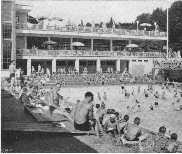
Abb. 7. Schwimmbad, gegen das Terrassen-Restaurant (gegen Osten).
