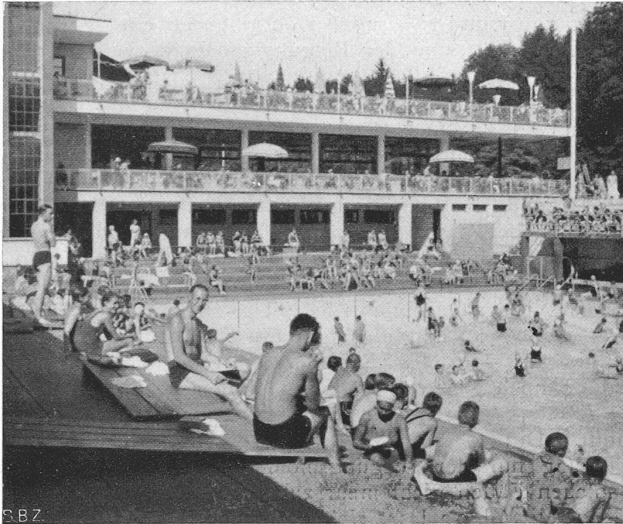
Abb. 7. Schwimmbad, gegen das Terrassen-Restaurant (gegen Osten).
