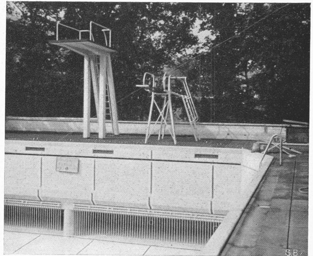
Abb. 12. Wellenaustritt am Tiefende des Schwimmbeckens.
