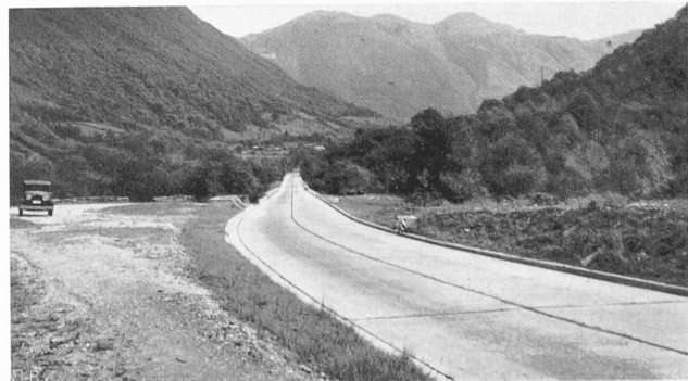
Abb. 10. Betonstrasse mit Griffbelag Ceneri Südrampe, bis 9% Neigung.
