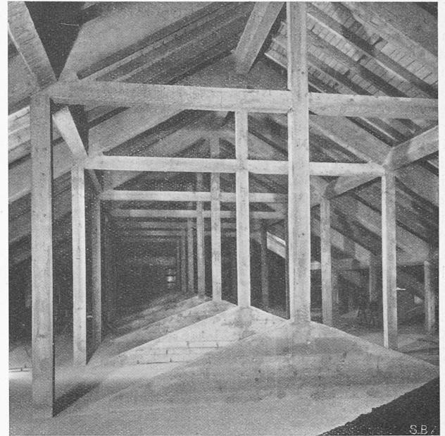
Abb. 4. Ansicht des durch Riegeleinbau verstärkten Dachstuhls.
