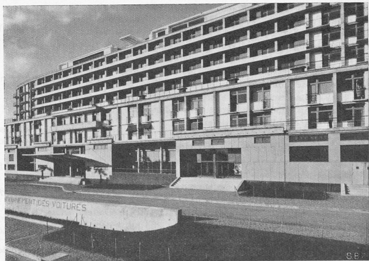
Abb. 8. Südfront des Hotels der „Cité sanitaire de Clairvivre“.
