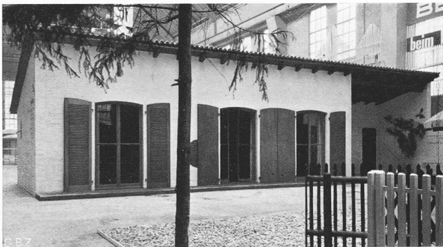
Abb. 17. Das Ziegelhaus (Nr. 15) aus Backstein mit Klosterdach.
