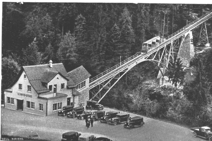
Drahtseilbahn Schwyz-Stoos, Talstation mit der Brücke über die Muotaschlucht (Brücke ebenfalls von uns geliefert).
