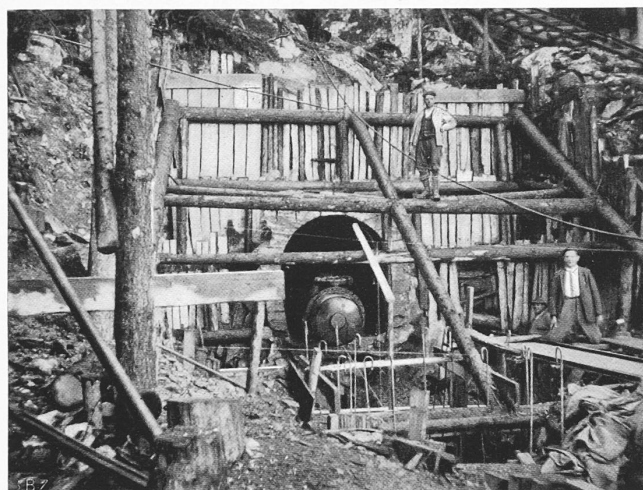
Abb. 41. Mündung des Rohrstollens in die (noch nicht erbaute) Apparetkammer.
