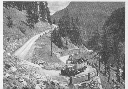
Abb. 36. Flüelastrasse mit ausgebauter Kehre.
