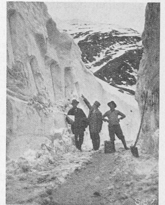
Abb. 32. Spuren der Schneeschleuder beim stufenweisen Abbau harten Lawinenschnees in der Val Tremola.
