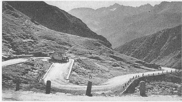
Abb. 30. Kehren A und B aus Abb. 29; R 1 4,5 m, R a 9 m, Strassenbreite 7 bis 8 m.
