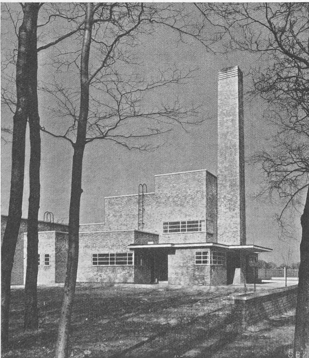
Abb. 21. Bergarbeiter-Bad in Snowdon, Kent. Architekt C. G. Kemp.
