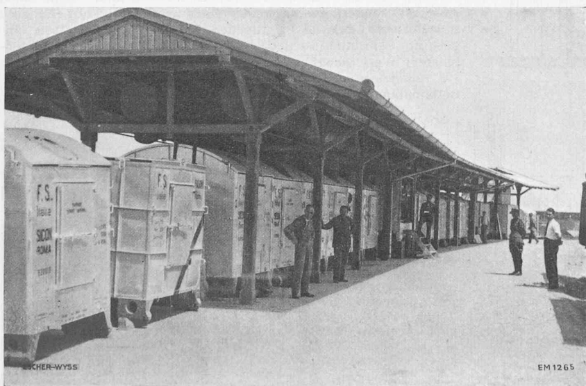
Abb. 9. Gesamtbild der nach Italien gelieferten transportablen EWAG-Kühl-Behälter-Anlage.
