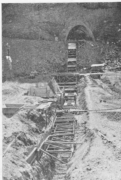
Abb. 5. Linksufriger Schutthang mit Schlitz und Einbau.
