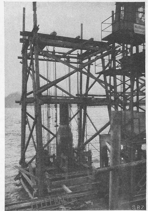
Abb. 7. Absenken eines Caissons der äusseren Reihe.
