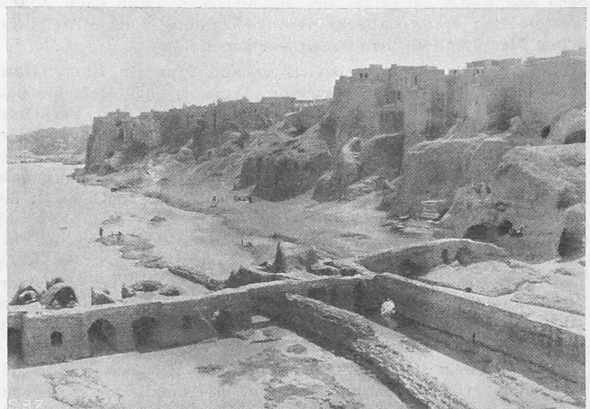
Abb. 16. Mühlräder oberhalb der Strassenbrücke in Disfoul.
