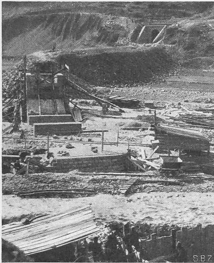
Abb. 6. Brücke über den Talar bei Km. 184,7, hinten Tunnel-Portal.
