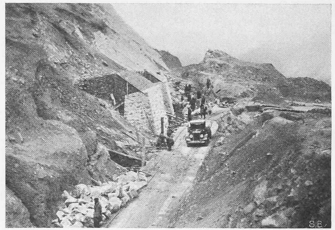
Abb. 5. Einschnitt bei Km. 190,5.
