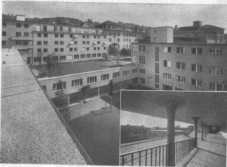
Schweizerische Pflegerinnenschule Zürich Terrassen- und Dachbeläge mit Asphalt- Gewebeplatten „Mammut“ Architekten Gebr. Pfister, Zürich
