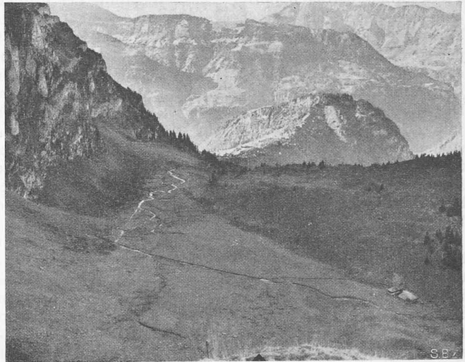
Abb. 3. Blick über die Bannalp (Dammbaustelle), nach Westen.
