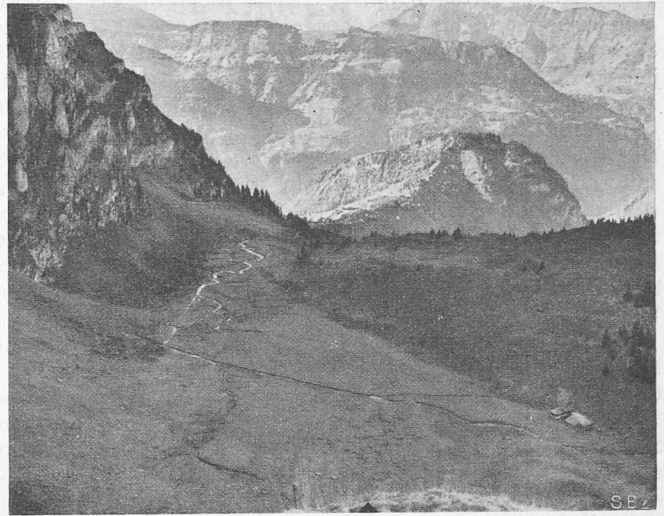
Abb. 3. Blick über die Bannalp (Dammbaustelle), nach Westen.
