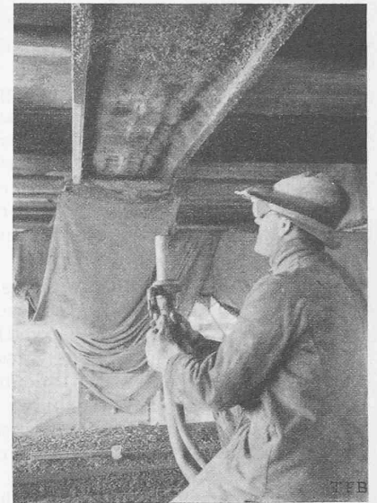
Abb. 3. Gunitieren eines Unterzuges.
