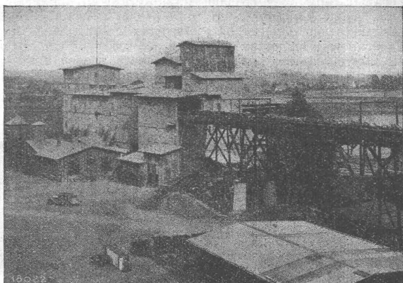
Schotter- und Edelsplittbereitungsanlage Leistung 200 t Basalt pro Std.
