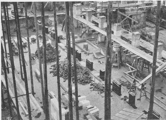
Abb. 9. Baubild mit den aufsteigenden Lüftungskanälen.
