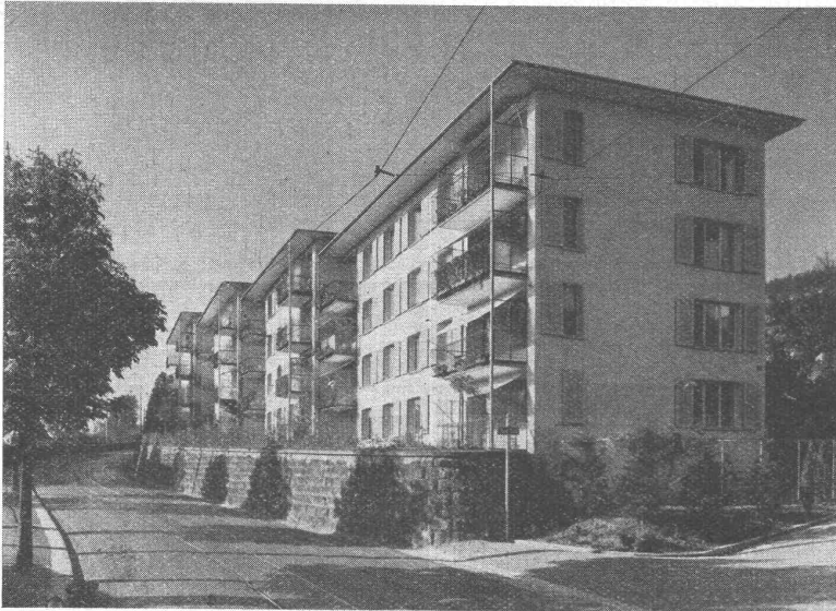
WOHNKOLONIE OERISTEIG, ZÜRICH Allgemeine Baugenossenschaft, Zürich Architekten: Kellermüller & Hofmann, Zürich
