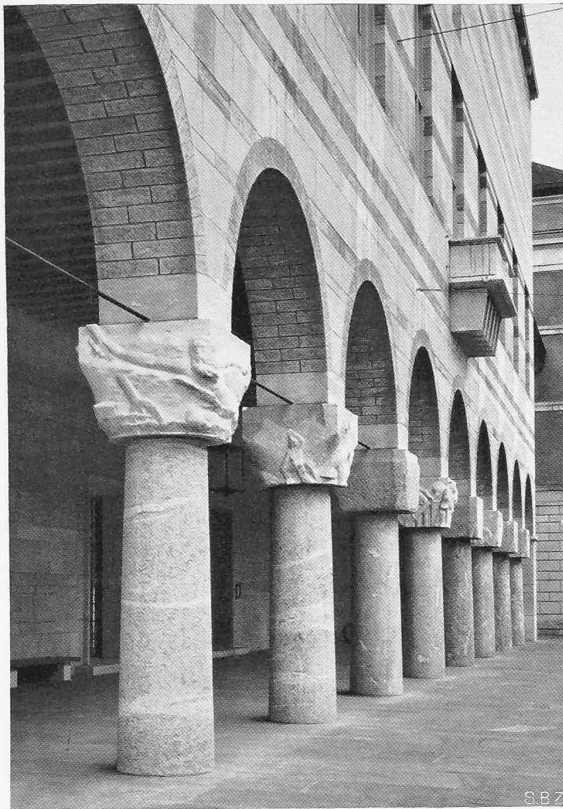
Arkade am Albangraben. — Säulen Tessinergranit (Kapitälé unfertig), Mauerfläche Kalkstein u. Granitbänder, Decke Eisenbetonbalken
