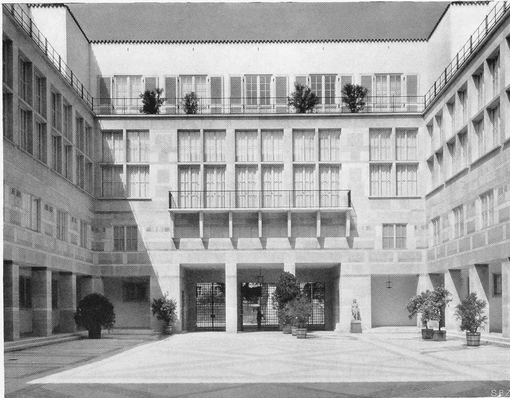
Der grosse Hof, gegen den Albangraben. Bodenbelag verschiedenfarbige und verschieden bearbeitete Kalksteine, Wände Solothurner und Othmarsinger, Bänder Andeer- und Tessiner-Granite, Obergeschoss verputzt
