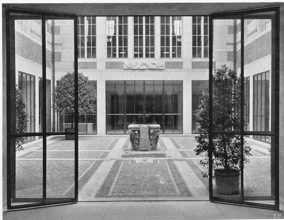
DAS NEUE BASLER KUNSTMUSEUM Der kleine Hof mit altvenezianischem Pozzo in rosso di Verona, Bodenpflasterung in farbigen Rheinkieseln zwischen gelben Lauffenerkalk-Bändern, Wände naturroter Backstein zwischen Laufener und dunklern Neuenburger Kalkbändern
