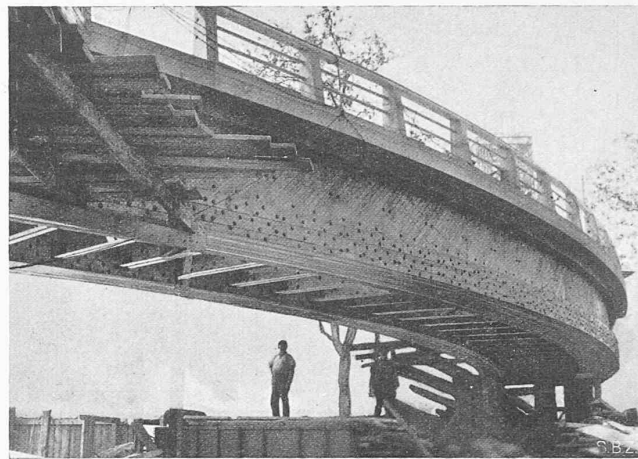
Abb. 1. Kurvenbrücke von 40 m Radius und 35 m Spannweite
