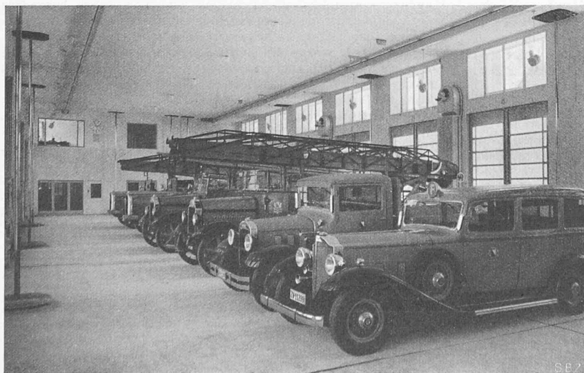
Abb. 14. Die Gerätehalle, links Ausfahrt, hinten Fenster des Feuermelderraums
