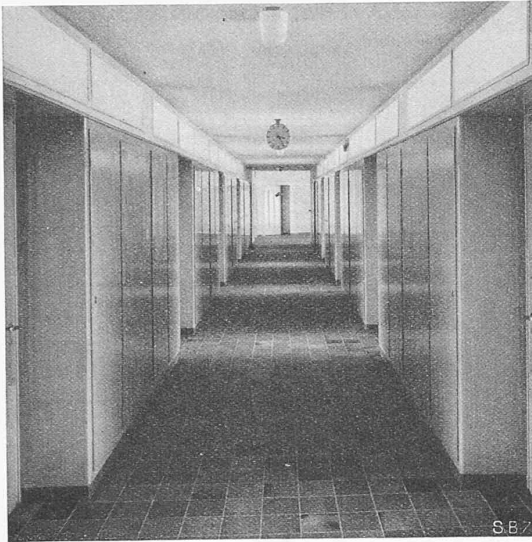
Abb. 9. Korridor zwischen den Schlafräumen
