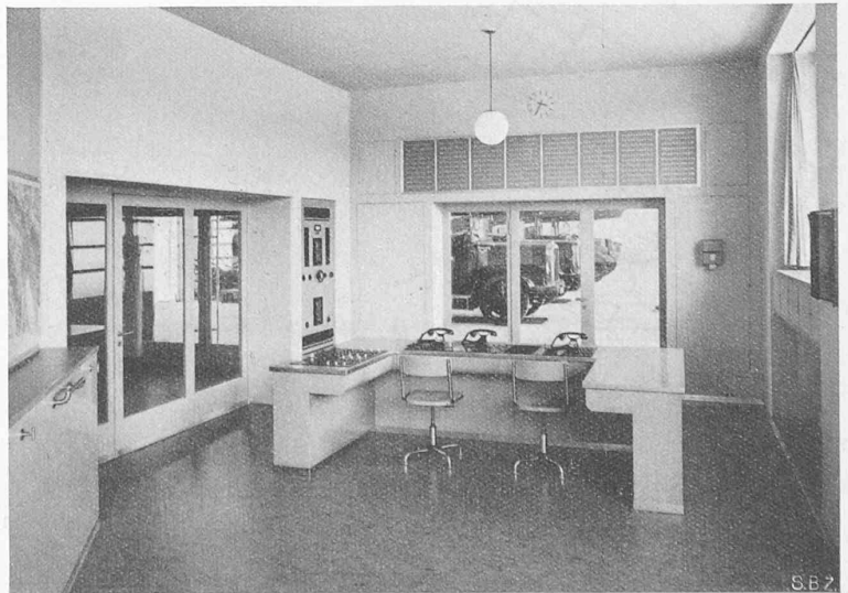
Abb. 13. Feuermelderaum im Erdgeschoss mit Uebersicht der Gerätehalle
