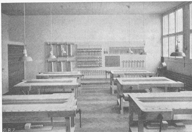
Abb. 17. Hobelraum (Untergeschoss, Nr. 36)
