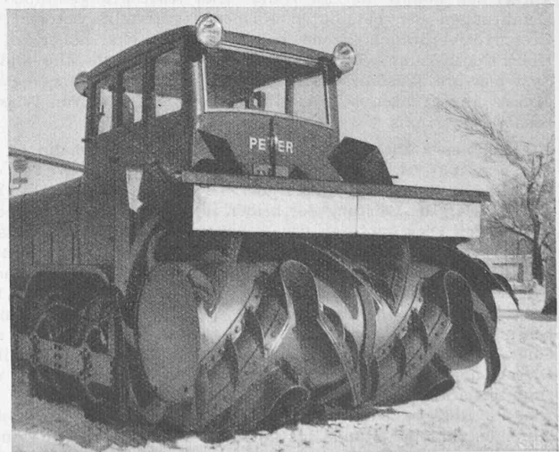
Abb. 6. Vorderansicht der Schleuderwalzen.
