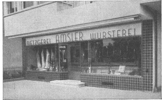
Schaufensteranlage inkl. Metalltüre sowie Bronzeschrift montiert vor durchleuchtetem Opalübergangglas.
