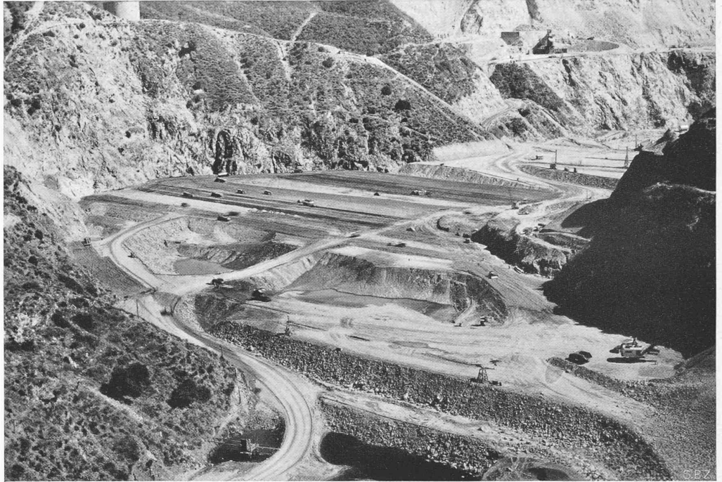
Abb. 3. Bauzustand vom Oktober 1936, von der Oberwasserseite. Im Hintergrund rechts oben der Steinbruch mit der Schüttelsiebanlage
