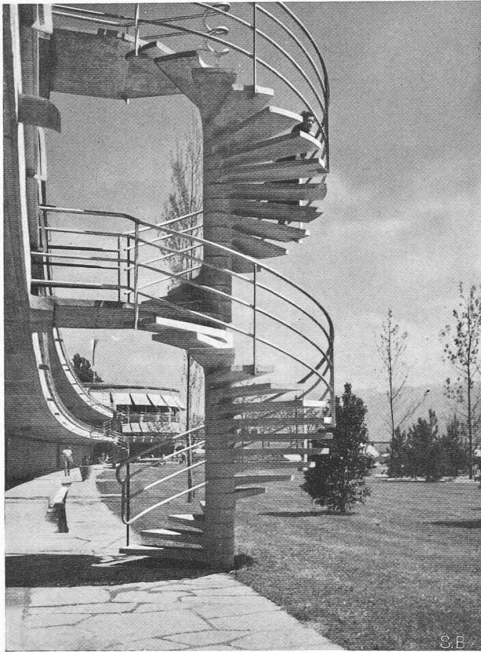
Abb. 17 (links). Wendeltreppe z. Frauen-Abtlg. und zur Dachterrasse
