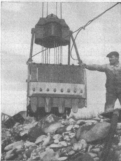
Verwendung von Stahlseilen in Greifbaggern
