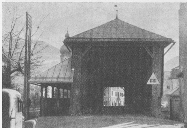
Abb. 2. Durchblick mit flussabwärts angebautem Gehsteg
