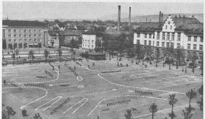
Geplante Verkehrsführung Wettsteinbrücke-Albangraben und -Dufourstrasse in Basel, auf dem Mustermessplatz in Naturgrösse aufgemalt zur Erprobung ihrer Zweckmässigkeit und allfälliger Aenderungen
