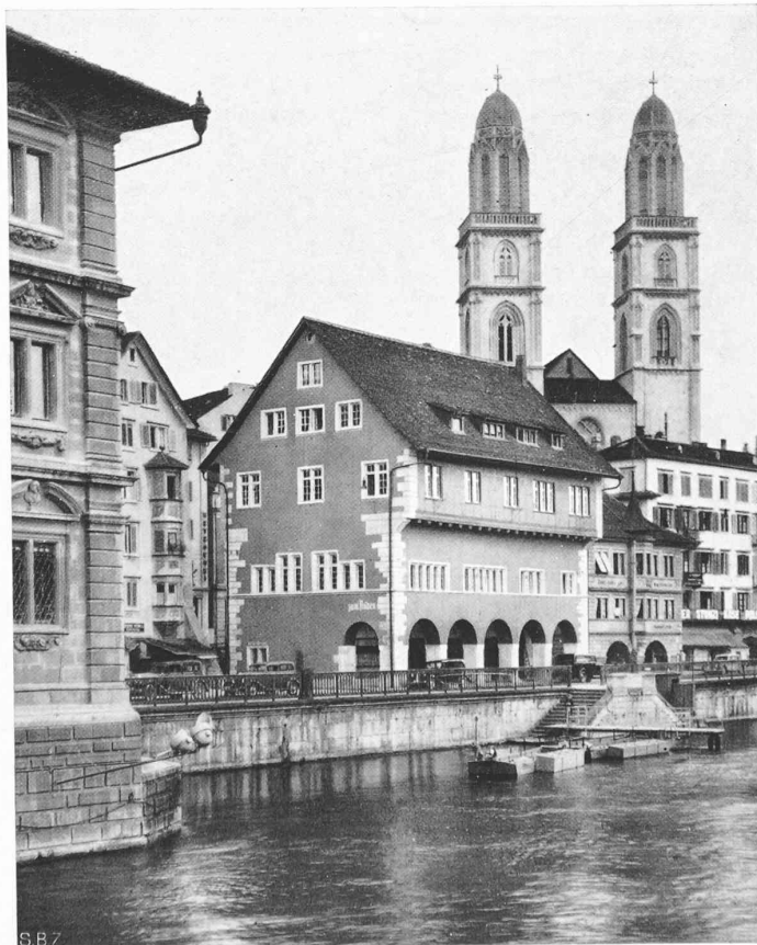
Der wiederhergestellte «Rügen» von der Rathaus- brücke gesehen
