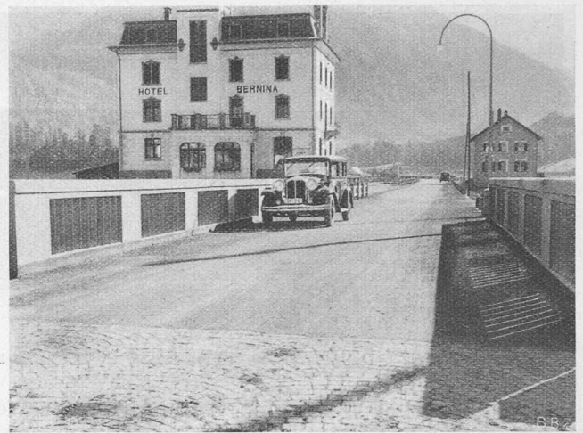
Abb. 19. Innbrücke Celerina, gegen Pontresina gesehen
