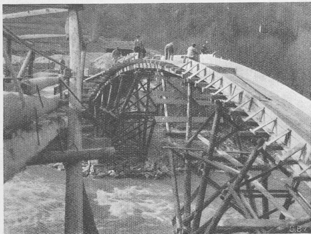
Abb. 28. Lehrgerüst und Bogenschalung Punt de Brulf
