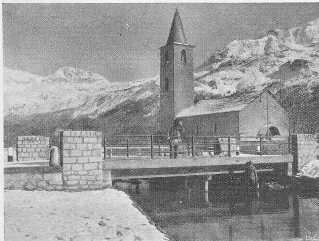
Abb. 21. Brücke über den Inn bei Sils-Baselgia, Oberengadin
