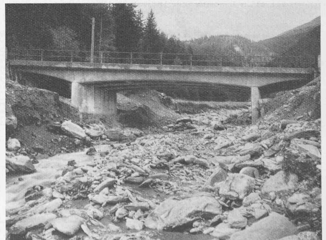
Abb. 24. Plattenbalken-Brücke im Val Ruinains, Unterengadin
