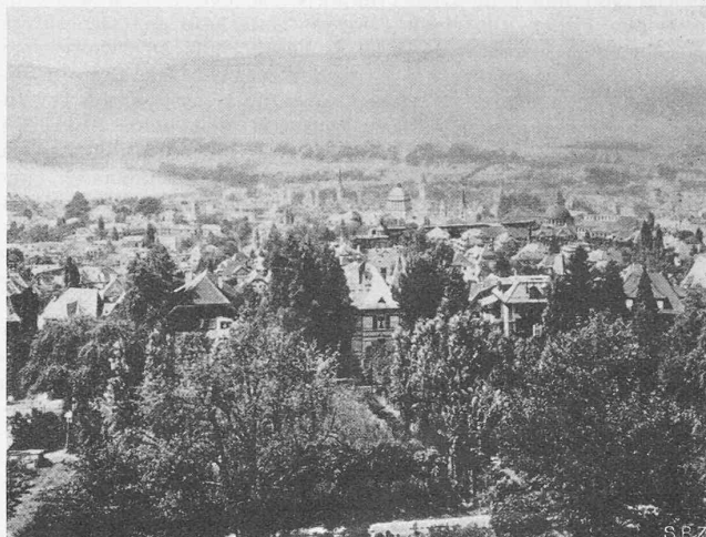
Abb. 3. Projektierter Kantonsspital vom Zürichberg aus
