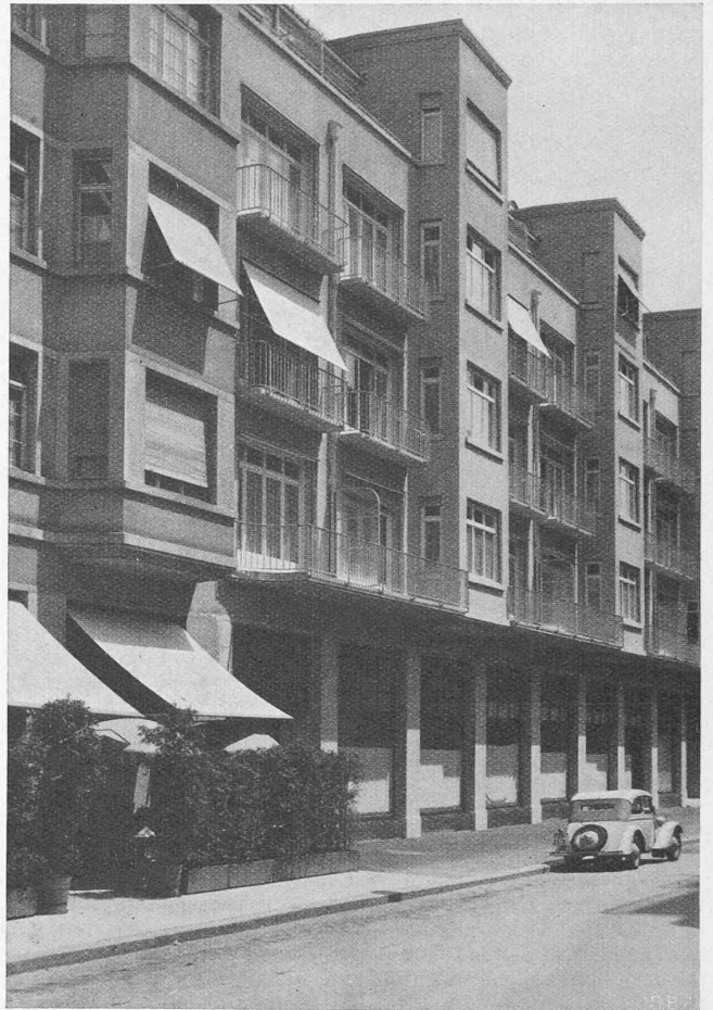
Abb. 1. Appartementhaus «Muralto» Zürich. Arch. H. WEIDELI
