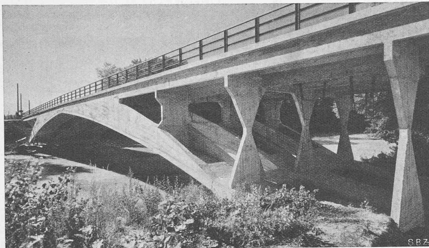
Abb. 10. Strassenbrücke über die Arve bei Vessy, Kanton Genf. Ausführung E. FAVRE
